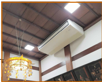
本堂内に6台のエアコンを設置
